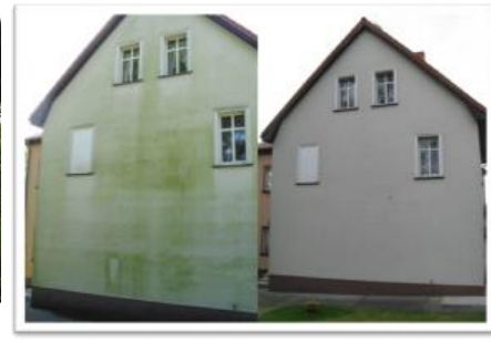
Fassade vorher und nachher
