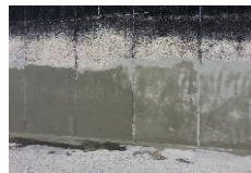
Alte und teilweise Beschichtung
